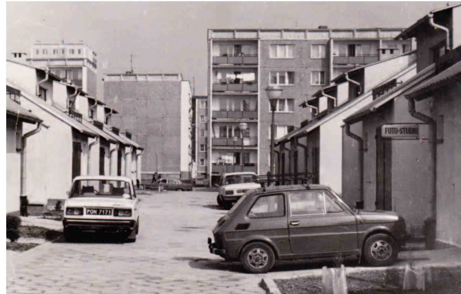
▲ DOMKI NA OS. KOŚCIUSZKOWCÓW, fot. Z. Ceglarek Houses in the Kościuszkowców housing estate / Häuser in der Kościuszkowców- Wohnsiedlung
