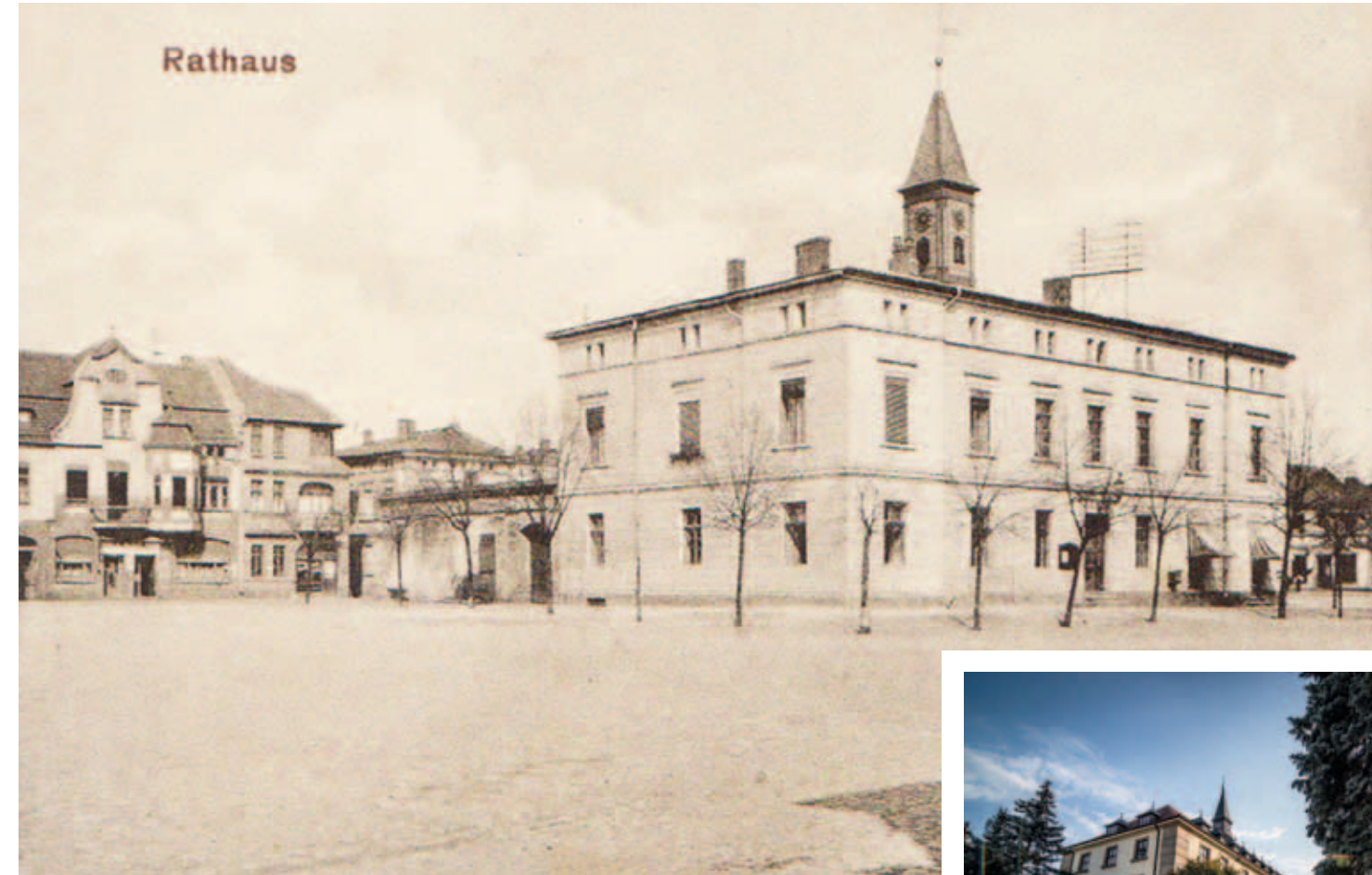
▲ RATUSZ Z NIEISTNIEJĄCĄ OBECNIE CZĘŚCIĄ PARTEROWĄ, OK. 1909 R.
