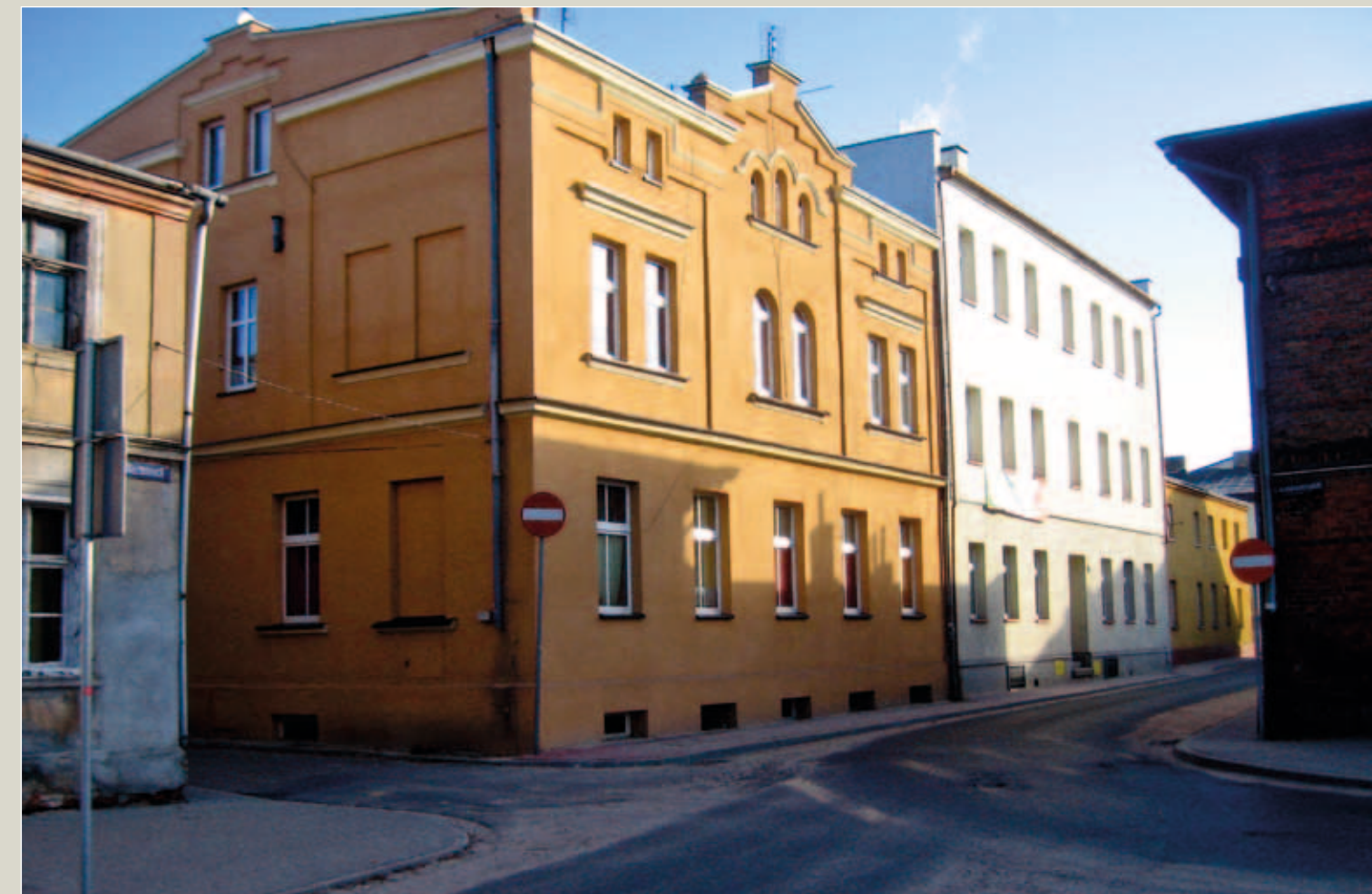
▲ PRZEDSZKOLE JARZĘBINKA PRZY PLACU NIEZŁOMNYCH, 2017 R., fot. B. Nawrocka
