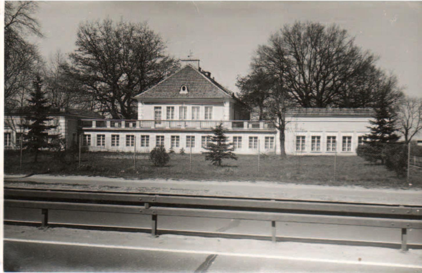
▲ BUDYNEK ŻŁOBKA PRZY ZAKŁADOWYM SWARZĘDZKICH FABRYK MEBLI, UL. POZNAŃSKA, LATA 80. XX W.
