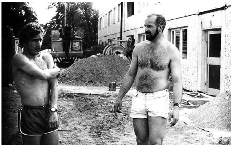
📍 Wiesław Zaporowski i Włodzimierz Kaźmierczak podczas budowy hotelu
