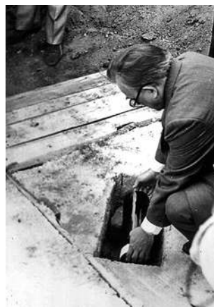
📍 Wicepremier Edward Kowalczyk wmurowuje kamień węgielny pod halę sportową
